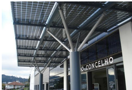
Figura 3.13 - Dispositivo fotovoltaico de sombreamento [15]
