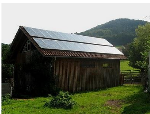
Figura 3.1 - Cabana com aproveitamento fotovoltaico [13]
